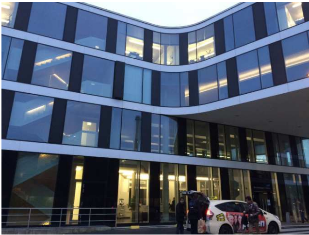
会場となった FEV の建物前
